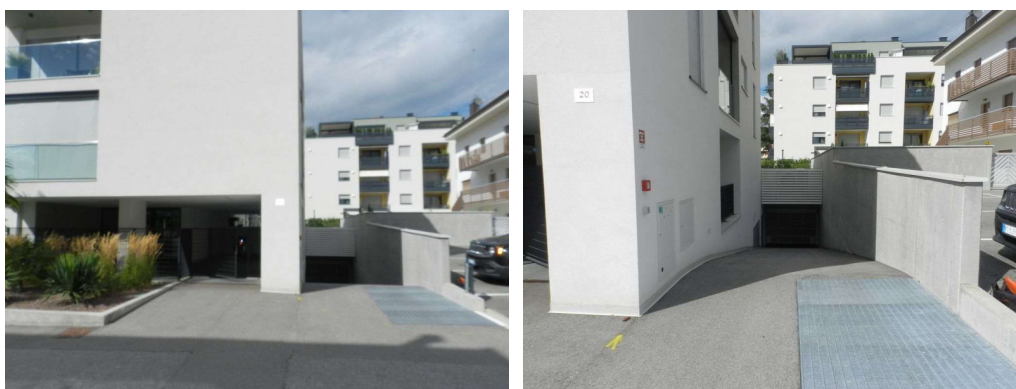
vista nuovo condominio Villa 1910 da via G. Garibaldi e l'inizio rampa per il p. interrato
