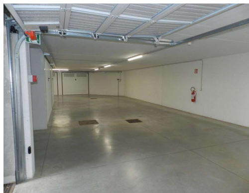
corsia di manovra del p. interrato alla base della rampa
